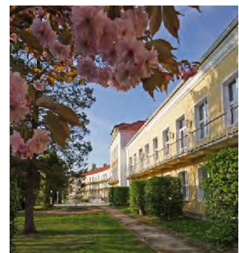
Thüringisches Hotel vor der energetischen Sanierung Quelle: pr
